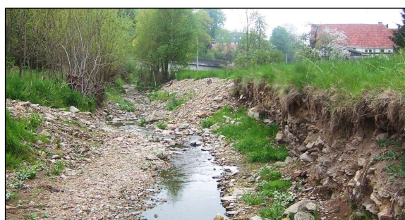
Erozja boczna Potoku Reichstädter Bach po powodzi w czerwcu 2013
