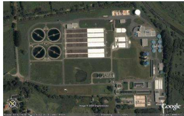
Widok z góry na Oczyszczalnię Ścieków w Chemnitz (źródło: google)
