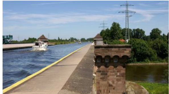
Wasserstraßenkreuz in Minden
